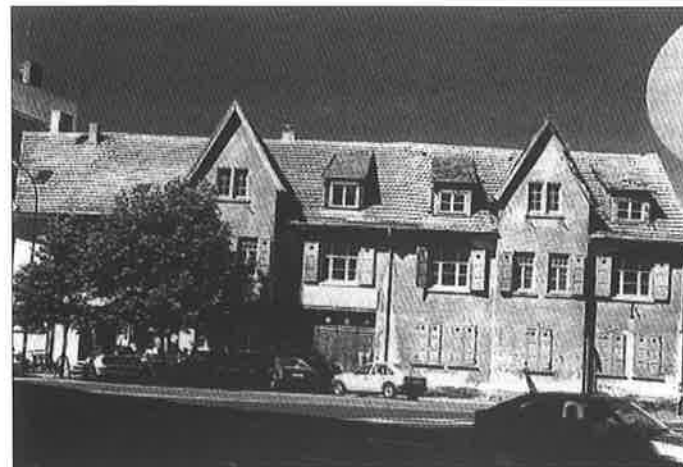
Das Verwaltungsgebäude der Seifenfabrik an der Breitenbacher Straße
