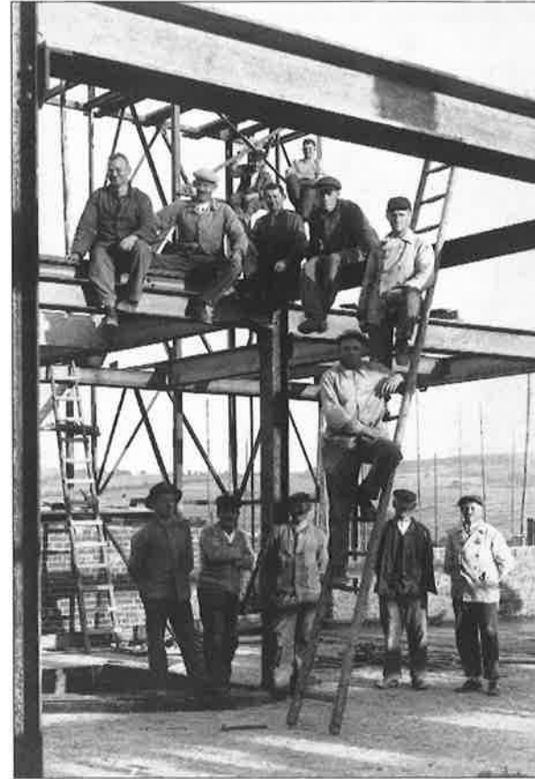
Ein Foto von 1929, als die Dreiturm-Werke in Steinau gebaut wurden. Auf dem Gerüst sitzend von links nach rechts: Philipp Denhard, Wilhelm Amend, Peter Heßler, Albert Romeiser; darüber: Julius Merz; auf der Leiter oben: Wilhelm Wolf; unten: Heinrich Klärle
